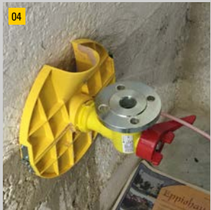
SCHRITT 04: Hauseinführung wird von der Gebäudeinnenseite mit Schuck Beto-Fix Plus vergossen.
