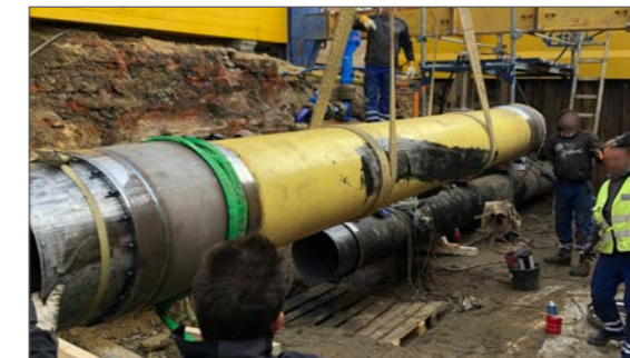
MUSTERBAUSTELLE SCHUCK ÜBERSCHIEBER SU
