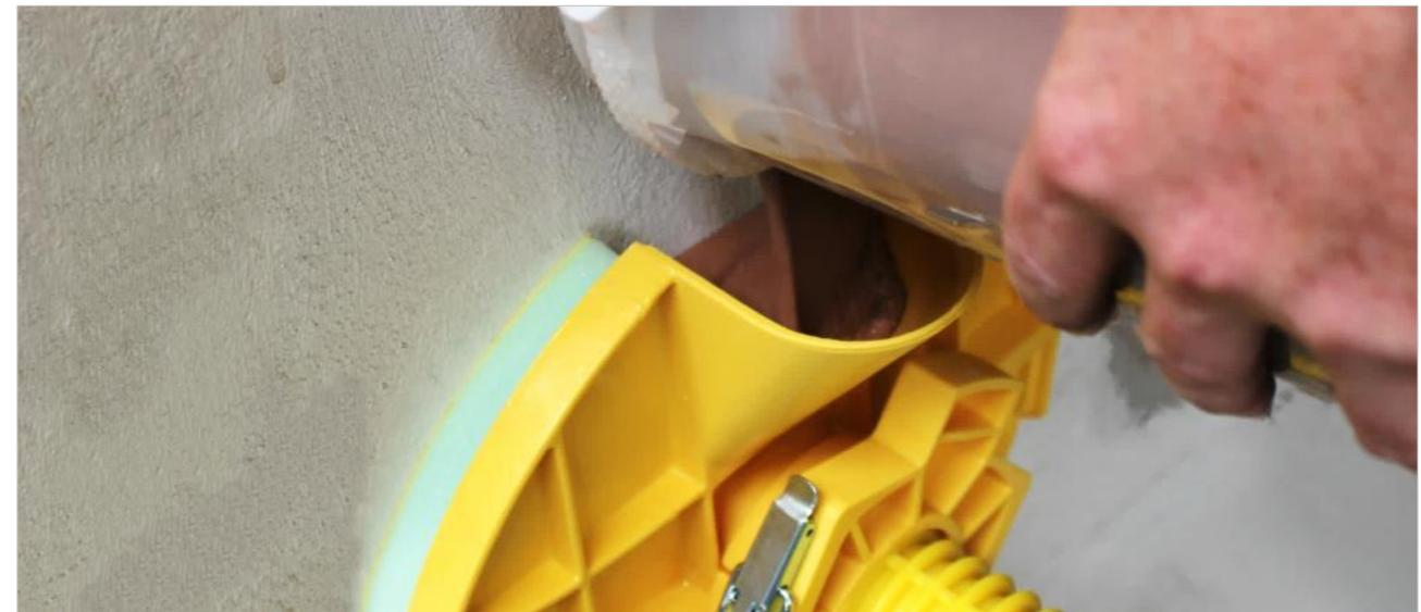
» Wenn der Pegel im Trichter nicht weiter absinkt ist die Kernbohrung komplett befüllt.
