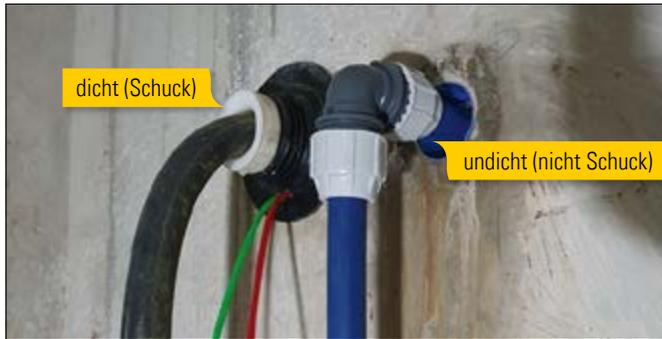
Gegen diese problematische Gemengelage aus fehleranfälligen Produkten, mangelhaftem Einbau und Schäden durch Wasser gibt es eine sichere Lösung: **Schuck Beto-Fix Plus**
