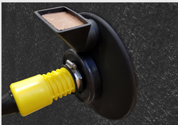
Bild 6: Dichtflansch mit Fülltrichter, Kernbohrung komplett befüllt
