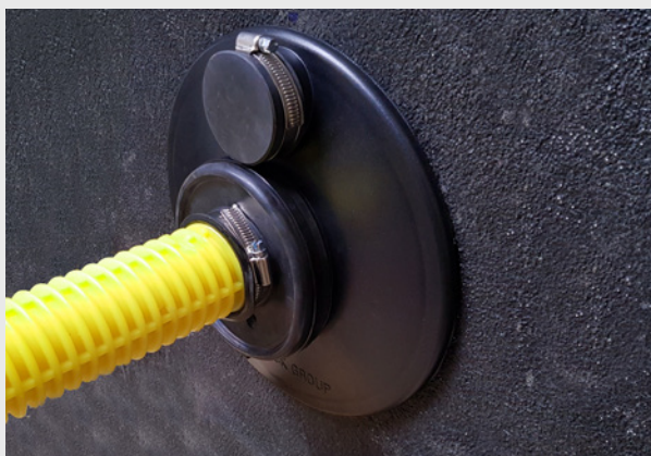
Bild 8: Fertig montierte Hauseinführung mit Anschluss bestehende PMBC (KMB) Gebäudeabdichtung durch den Dichtflansch 18533
